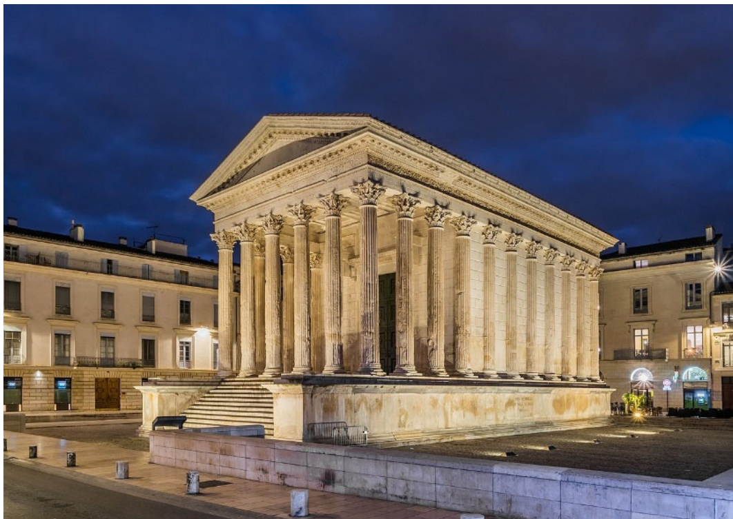
Image 3 - Photo Mise en lumière après la restauration de 2010
